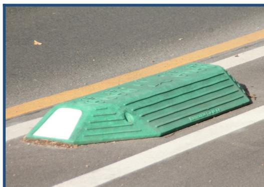
**Bemerkung:** Das Element erhielt eine der positivsten Bewertungen. Der Kunststoff dürfte bei Unfällen weniger zu Verletzungen führen als Beton. Auch die Kombination mit Pfosten an Ausfahrten wirkt sinnvoll.
