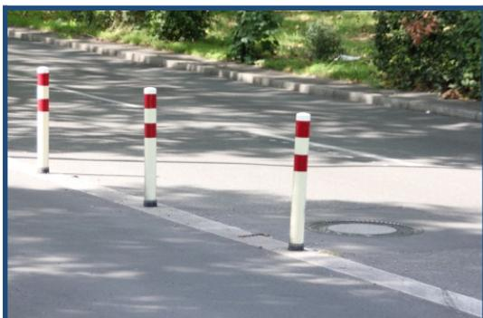
**Bemerkung:** Ohne Abstandszone besteht möglicherweise trotz Flexibilität eine Unfallgefahr für Radfahrende. Aber gerade an breznigen Stellen (mit sonst querenden Autos) dürfte es insgesamt eine hilfreiche Schutzmaßnahme sein.
