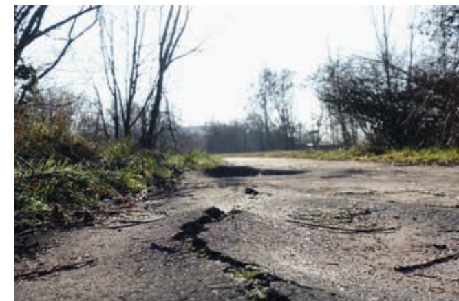
Wurzelaufbrüche verderben jeden Fahrspaß. An vielen Orten wie hier in Neukölln ist die Sanierung lange überfällig.
