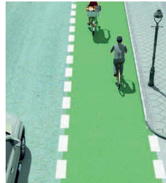
Schutzstreifen: Erkennbar an der gestrichelten Linie.
